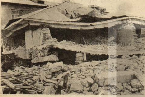
YAPI İŞ KOLUNDA, KÖTÜ MALZEME KULLANILMASI ÇÖKEN İNŞAATLAR HER YIL YÜZLERCE İŞÇİNİN HAYATINA MAL OLMAKTA
